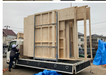
内壁の大型パネル化（写真2）。
