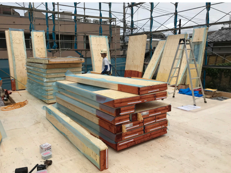
国内工場による外壁のフルパネル化（写真1）。
